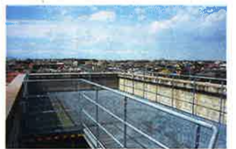
屋上に出来た一時避難場所 (海拔16メートル)
